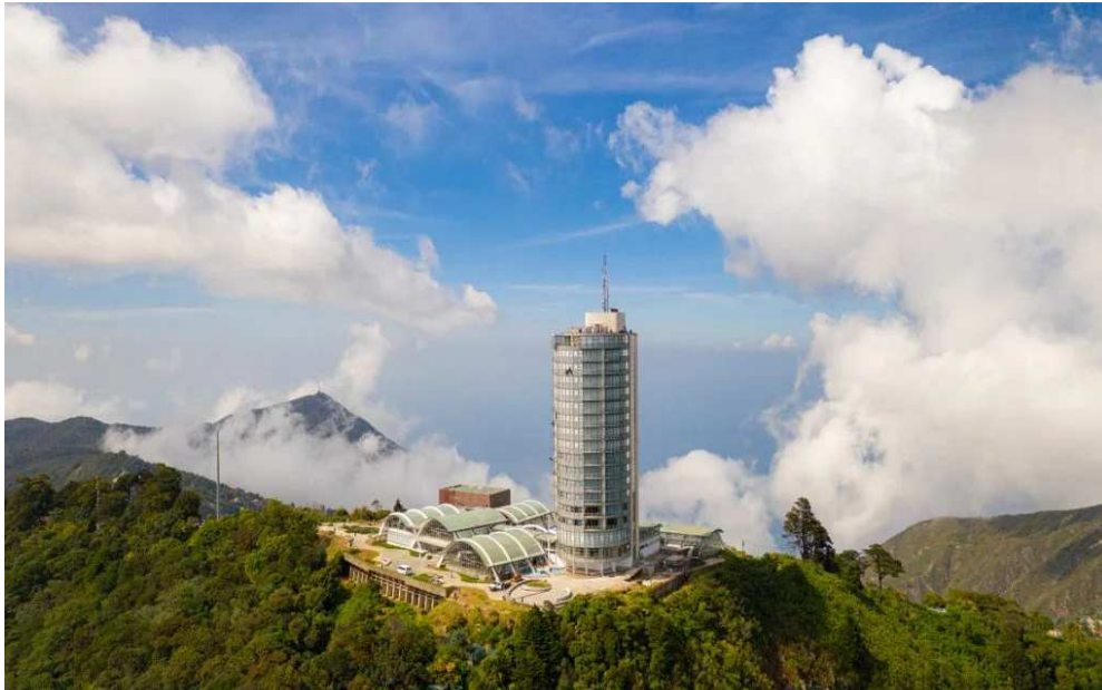
Vista aérea del Hotel Humboldt
