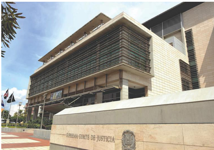
Edifício da Suprema Corte de Justiça
